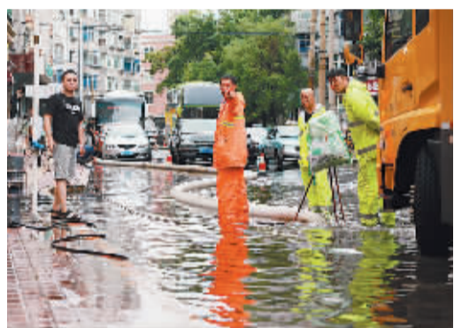
台风“利奇马”带来连续降雨,建设街积水严重。12日晨,记者在现场看到,西岗区市政公共事业服务中心工作人员正在排水。据现场工作的崔师傅告诉记者,他们于11日早6时起一直在此坚守作业。 本报记者姚壮 摄
