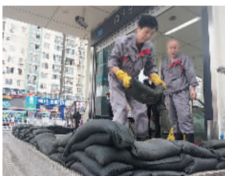
11日,工作人员在地铁2号线湾家站的站口垒好防汛沙袋,防止雨水灌入地铁口。 本报记者吕文正 摄
