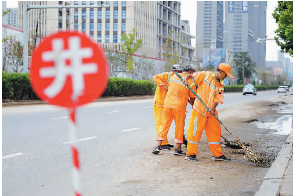
暴雨间歇期间,环卫工人加急清理道路淤泥和疏导地下排水。 本报记者王韬飞 摄
